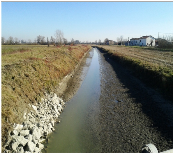
Il Collettore Alfieri prima dei lavori
