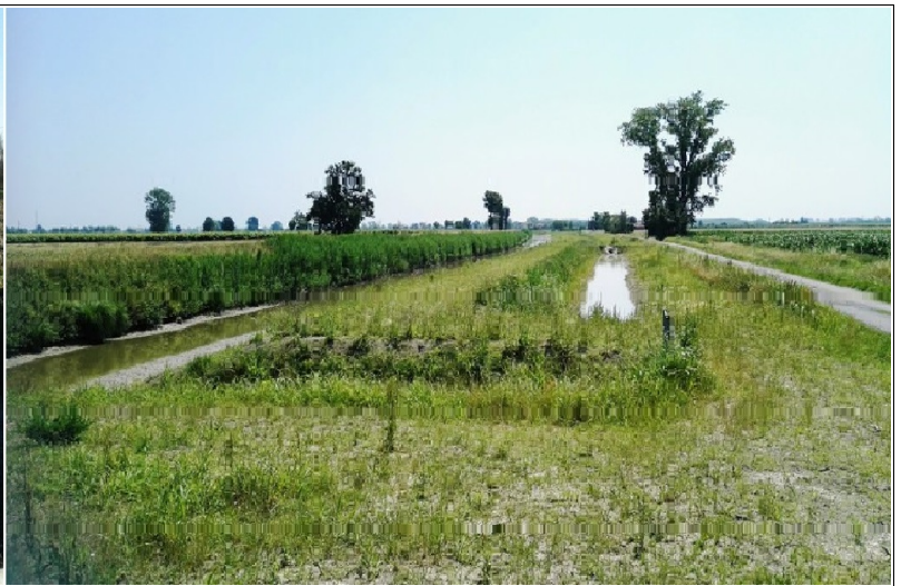
Il Collettore Alfieri dopo i lavori (giugno 2016)
